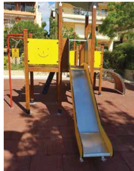
Ανακατασκευή 12 παιδικών χαρών
